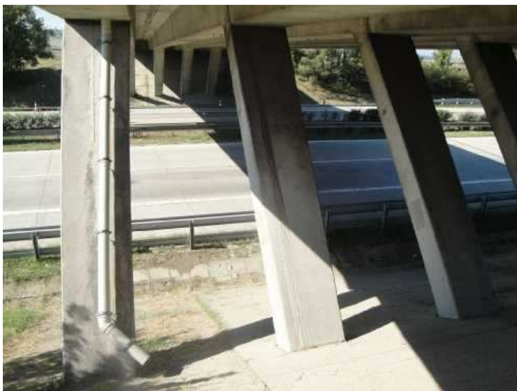
Odpadní trubka odvodňovače podpěry 2
