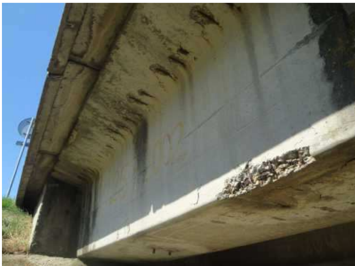
Detail trámu vlevo u podpěry 4, degradace betonu
