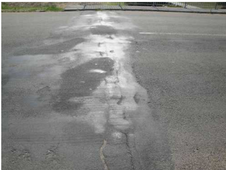
Vozovka v místě mostního závěru podpěry 1 - vysprávkky, trhliny, převýšení vozovky
