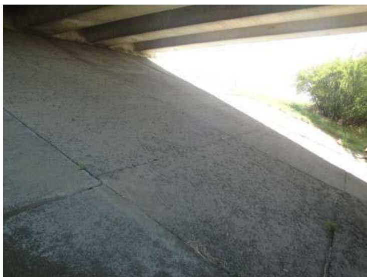
Zpevnění monolitickou deskou v 1. poli
