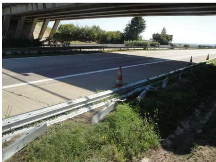
Území pod mostem, 2. pole - deformace svodidla u podpěry 3
