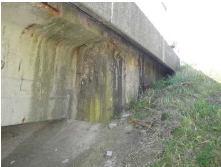
Pravé křídlo a konec podpěry 4 - dlouhodobé průsaky, degradace betonu, vyhřezlá výztuž
