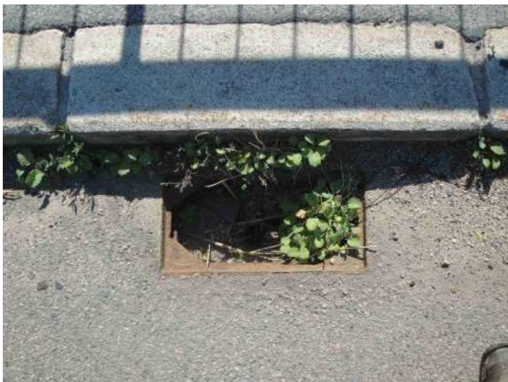
Vpust' odvodňovače vlevo - chybějící rošt vpusti
