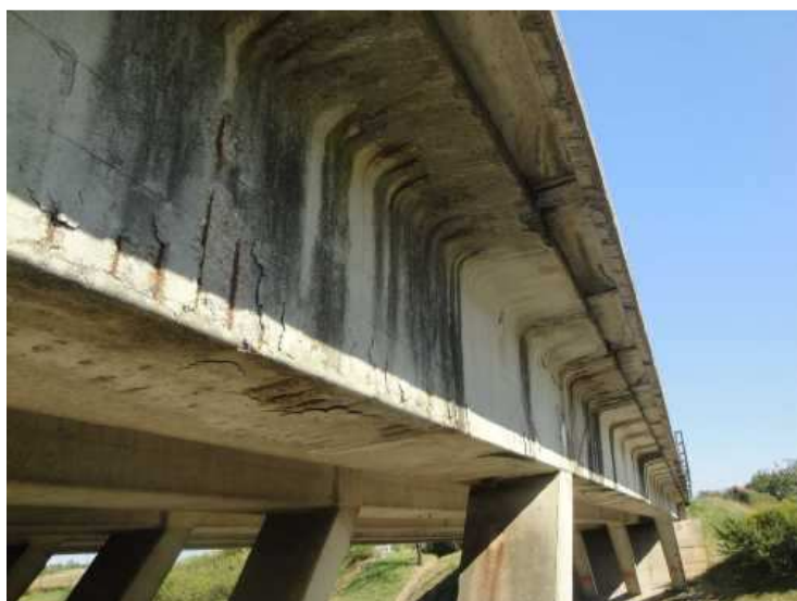
Fasáda trámu vpravo - degradace betonu, odražené krycí vrstvy, dlouhodobé průsaky
