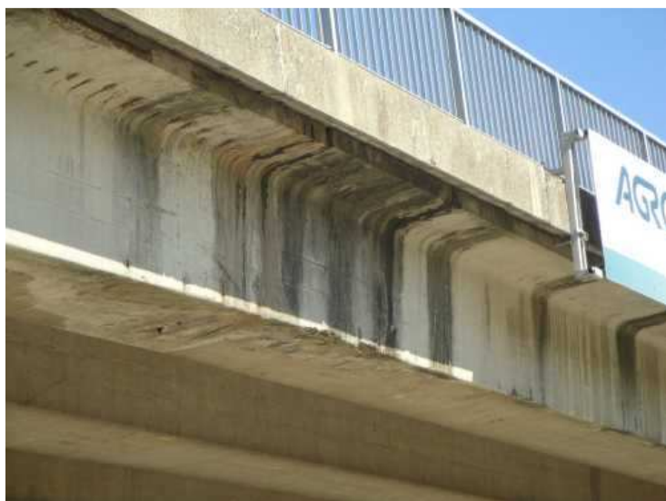
Fasáda trámu ve 2. poli vlevo, průsaky, degradace betonu, vyhřezlá výztuž
