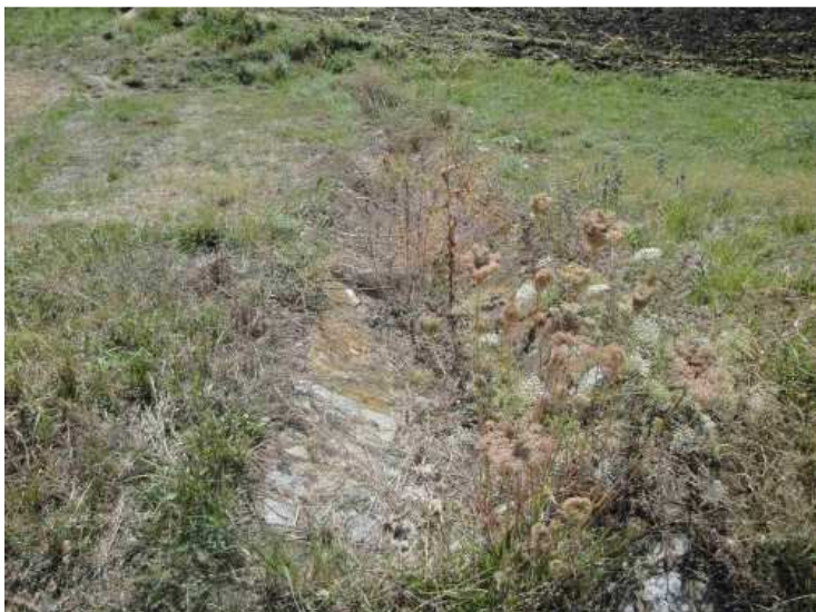
Odvodňovací žlab na silničním tělese - tvárnice zarostlé trávou
