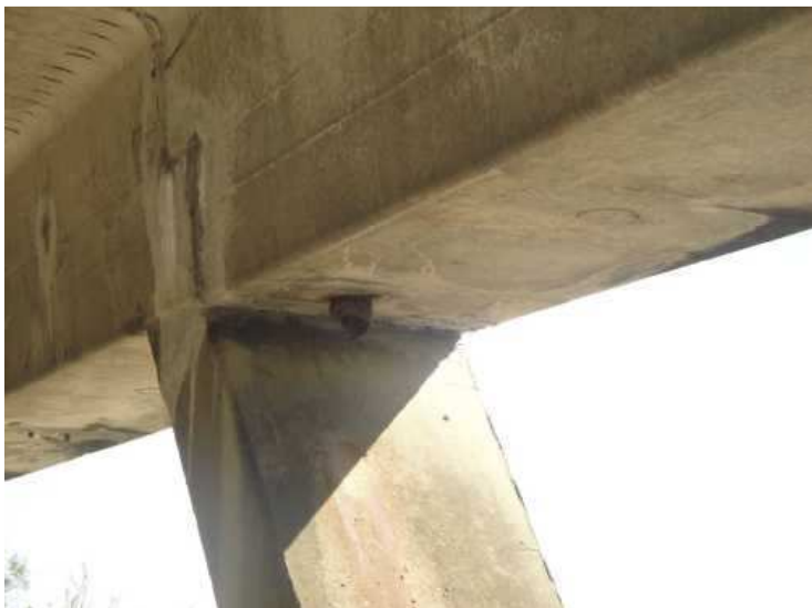
Detail vyústění odvodňovače u podpěry 3
