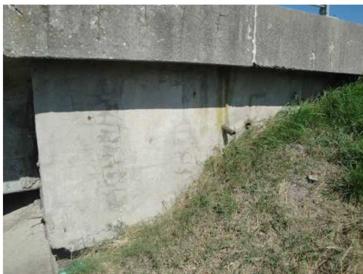
Levé křídlo podpěry 1, mapy, trhlinky v omítce
