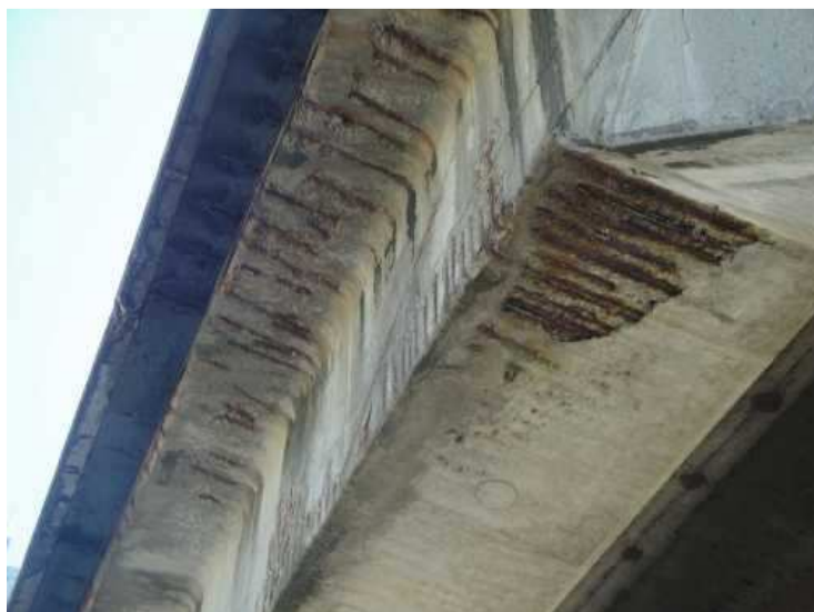
Detail trámu s napojením vnější vzpěry - degradace betonu, vyhřezlá korodující výztuž
