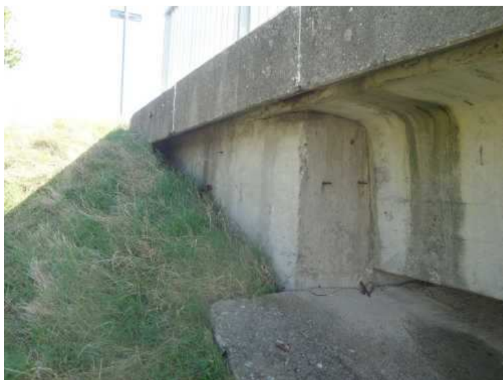
Pravé křídlo podpěry 1, pravý konec podpěry, dlouhodobé průsaky na fasádě NK
