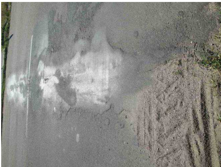
Vozovka v místě mostního závěru podpěry 4 - vysprávkky, trhliny, nerovnosti vozovky
