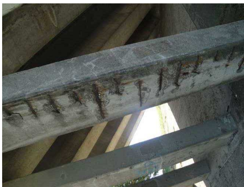
Detail pravé vzpěry podpěry 3 - vyhřezlá výztuž, odprýskávající krycí vrstvy betonu, degradace betonu
