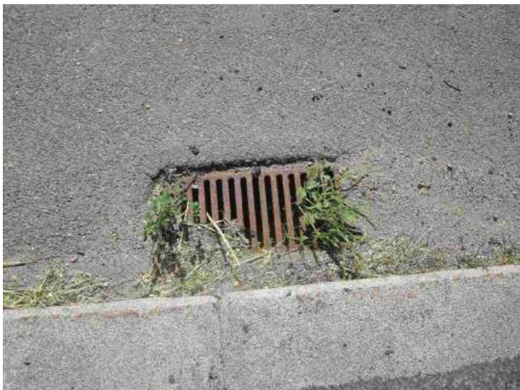
Vpust' odvodňovače
